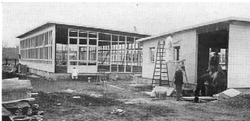
een den Hollanderschool in aanbouw
